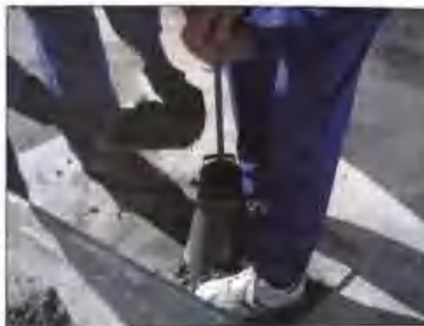
Figura 3.8. Momento de vertido de la masa en el cono y realización de las 25 ton-gadas por capa.
